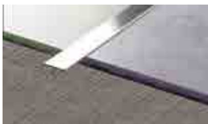
Installazione del profilo a "T"
