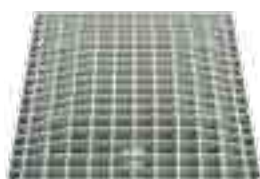
Vista struttura inferiore
