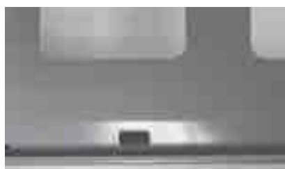
Fori per l'evacuazione dell'acqua sotto la piastrella
